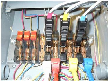
Introduzca las sondas de corriente continua en el conmutador de prueba. Mueva los conectores de tensión a las conexiones de corriente de la parte inferior. Conecte el cable blanco (Neutro) a la conexión de corriente de fase A situada en la parte inferior.
