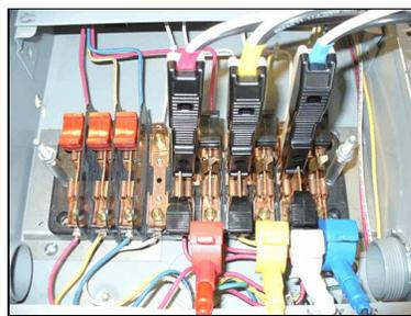
Mueva el cable blanco (Neutro) a las conexiones de corriente de la fase C situadas en la parte inferior.
