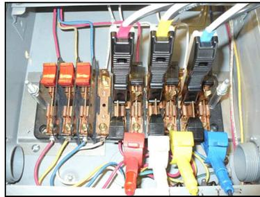
Mueva el cable blanco (Neutro) a las conexiones de corriente de fase B situadas en la parte inferior.
